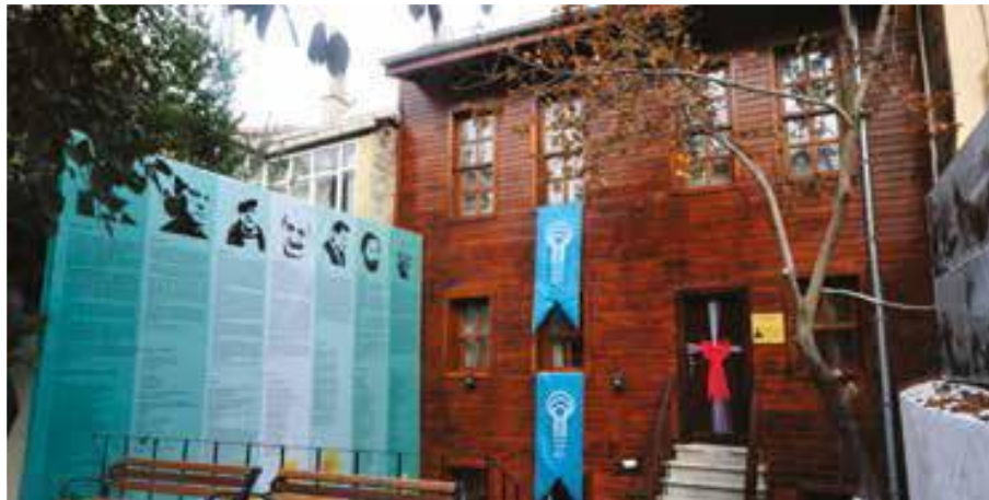
Sezai Karakoç Hizmet Binası
