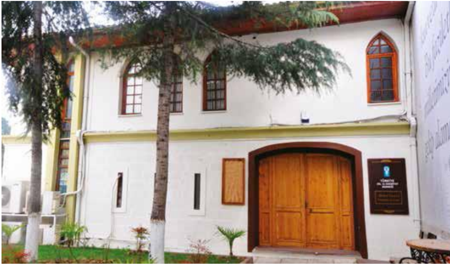
Ahmet Yesevî Hizmet Binası
